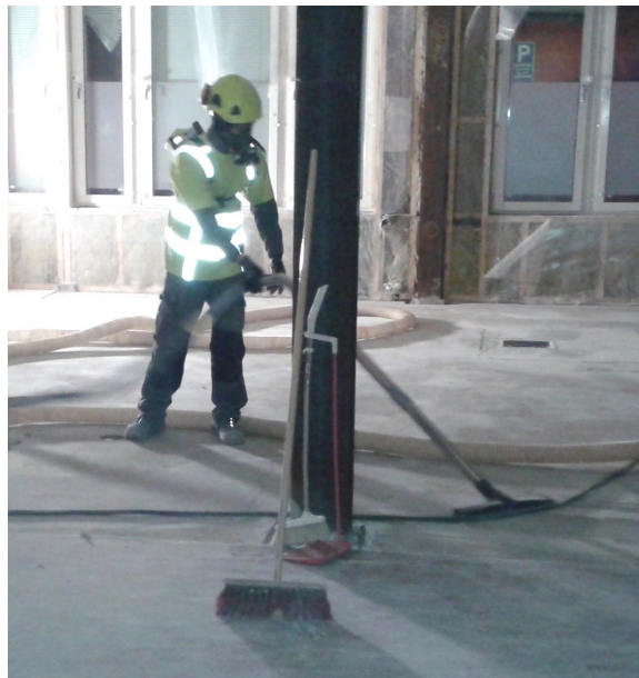
Dammsugning efter slipning av betonggolvet.
