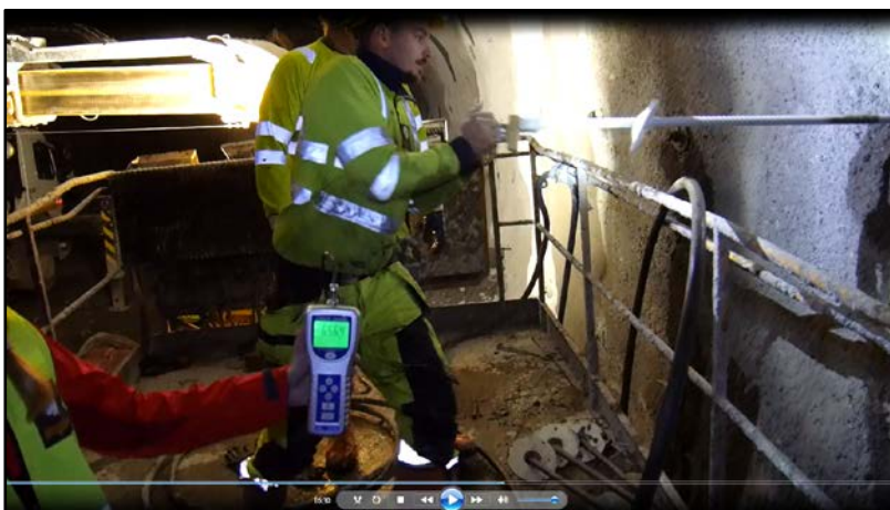
Figur 11. PC-bult. Sättning av bult i horisontalläge, studieperson 2. Normalt är bulttypen enkel att trycka in. I detta fall tycks bulten ha "fastnat" i på grus i hålet, därav den höga kraften på 656 N. Situationen avhjälpes genom korta gungande tryckningar (med hjälp av överkroppen som momentum) mot bulten. Även om en för bulttypen, ovanligt hög kraft krävdes, så var den mycket kortvarig. Eftersom situationen är dynamisk och inte en "vanlig" trycksituation, utfördes varken simulering eller biomekanisk beräkning.
