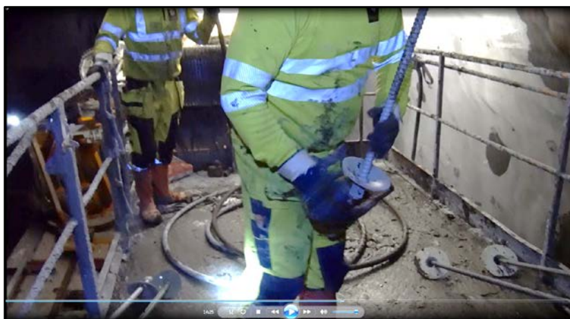
Figur 22. PC bult. Sättning av bult i uppåtriktat läge. Intryckningen av bulten gick lätt (bulten fastnade ej). Bulten sågs ut att "kastas" in i det ofyllda hålet. Ingen kraftmätning eller biomekanisk beräkning utfördes.
