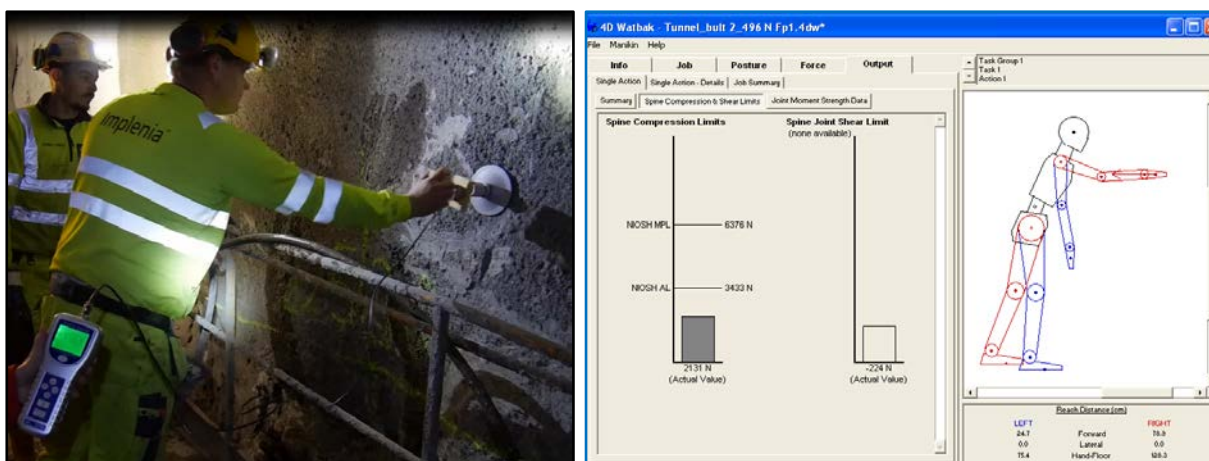
Figur 7. PC-bult. Sättning av bult i horisontalläge, studieperson 1. Maximal tryckkraft visar 496 N. En betydande kraftökning skedde just innan bulten var helt intryckt, innan dess var kraften lägre, ca 200 N. Simulerad kompressionskraft i ländryggen visar 2131 N.
