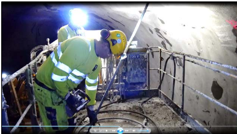
Figur 21. Kamstål bult. Sättning av bult i uppåtriktat läge. I början av intryckning används rampens golv som tryckkraft. Ingen kraftmätning eller biomekanisk beräkning utfördes.
