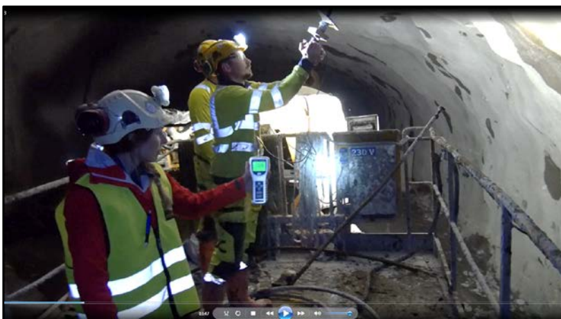
Figur 19. PC-bult. Sättning av bult i uppåtriktat läge, studieperson 2. PC-bulten är normalt så "lätt" att trycka in så man bryr sig inte om att använda hjälpdonet. Tryckkraften var initialt 153 N, därefter "fastnade" bulten. De ryck/slag som krävdes för att trycka in bulten innebar momentant höga krafter, här 515 N.
