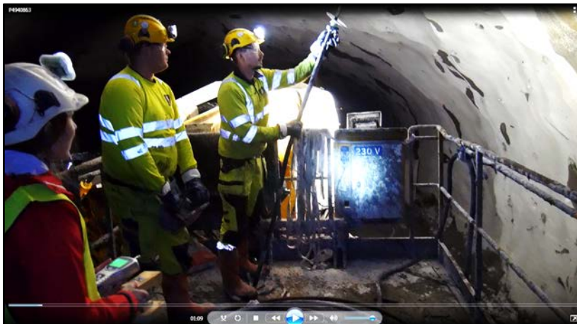
Figur 17. Kamstålbult. Sättning av bult i uppåtriktat läge med tryckhjälp av don som sätts mellan bultens ände och rampens golv. På så vis gör rampen "jobbet". Ingen kraftmätning eller biomekanisk beräkning utfördes.
