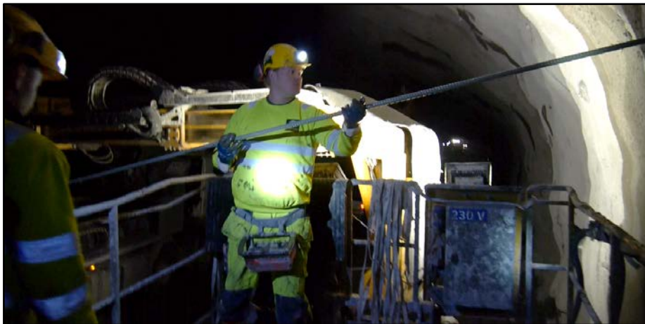
Figur 13. Kamstålbult. Exempel på hantering av bulten, som skall lyftas upp och riktas in i hålet.
