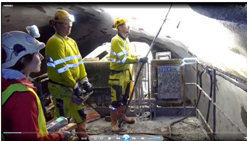
Figur 18. Kamstål-bult. Sättning av bult i uppåtriktat läge (samma som i figur 17) med tryckhjälp av don. Ingen kraftmätning eller biomekanisk beräkning utfördes.
