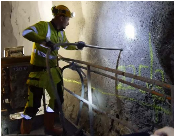
Figur 1. Betong pumpas genom en slang in i borrhålet.
