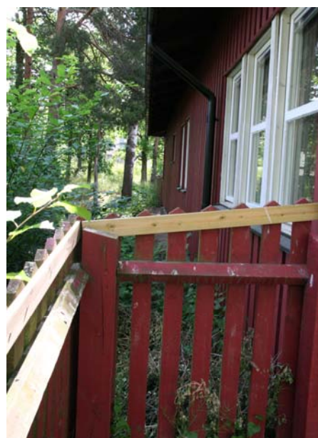
Huvudbyggnadens baksida utgör en del av avgränsningen av gården, trots att själva tomten ligger någon meter utanför huset. Där skulle kunna skapas ytterligare ett utrymme för barnen om man satte upp ett stängsel i tomtgränsen. Om dessutom framsidas hindrande stängsel tas bort skulle en passage skapas runt huset som uppmuntrar till att springa mer.
